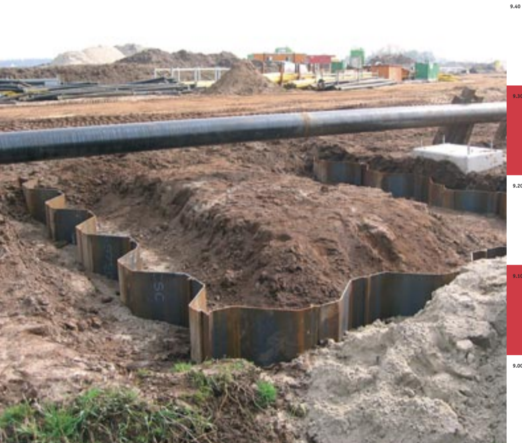
Damwanden zijn geplaatst om schade aan de olieleiding van de NAM te voorkomen
